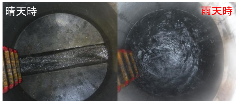
不明水が流入するマンホールの状況
