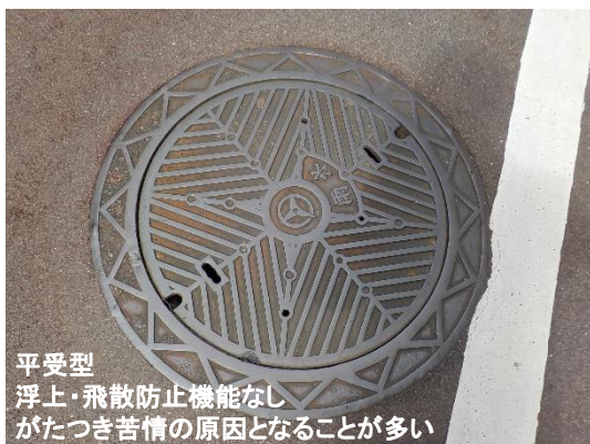
改築対象とするマンホールの例
