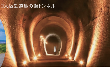
旧大阪鉄道亀の瀬トンネル
